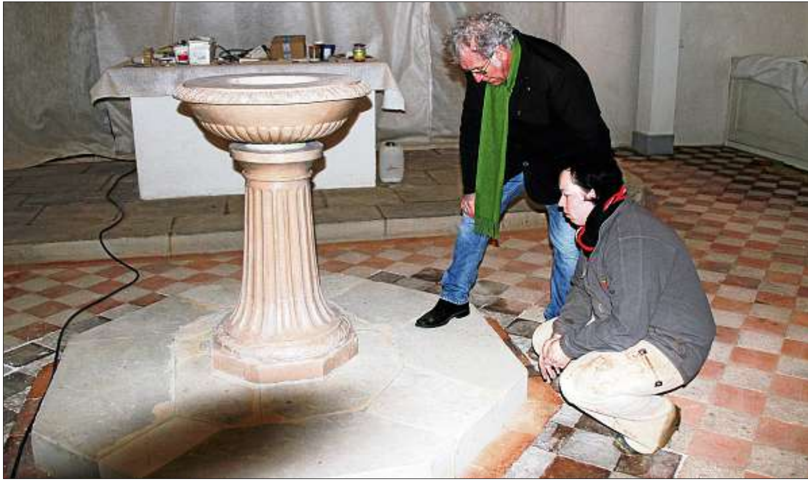
Udo Schneider vom Orgelförderverein und Christin Großheim von der die Steinarbeiten ausführende Fachfirma Schiecke am Taufstein der Rastenberger Coudraykirche. Das einst in den Boden abgesenkte Podest wurde wieder angehoben, der Taufstein aufgearbeitet.. Foto: Armin Burghardt
