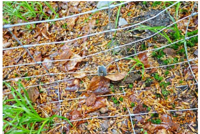
Abb. 4: Um die Weisergatter dauerhaft wilddicht zu halten, kommt der Absicherung nach unten eine große Bedeutung zu. An seiner Unterseite wurde der Zaun ca. 20 cm nach außen umgeklappt und durch Bodenanker zusätzlich abgesichert. In den kommenden Jahren soll der Zaun sukzessive in die Bodenvegetation einwachsen.
